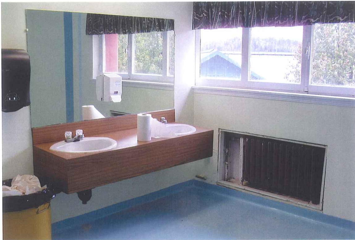
Salle de toilette type au 2e étage
