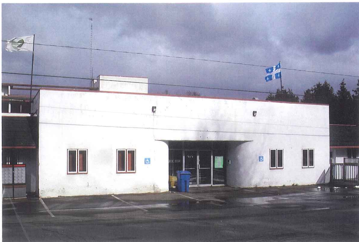
Bâtiment 2 - Vue en façade
