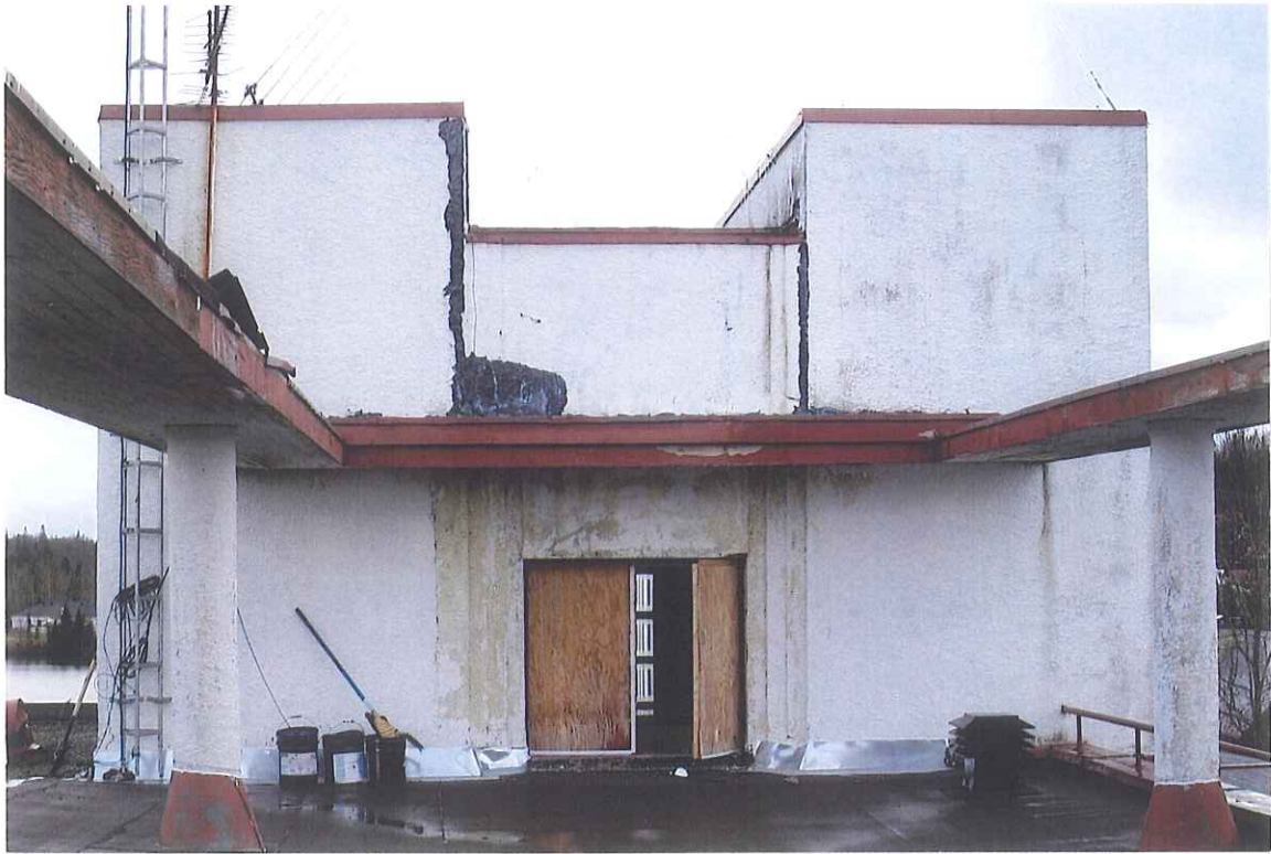
Bâtiment 1 - Sortie de secours / toit
