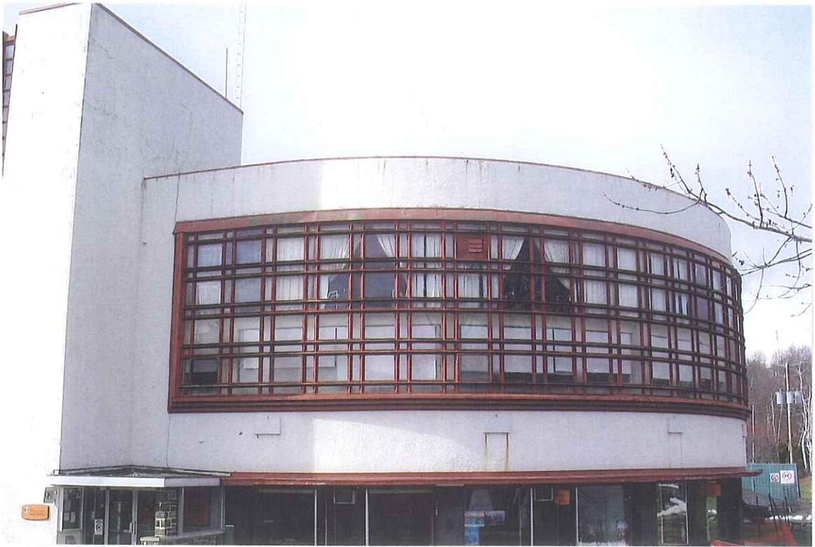
Bâtiment 1 - Vue partielle en façade
