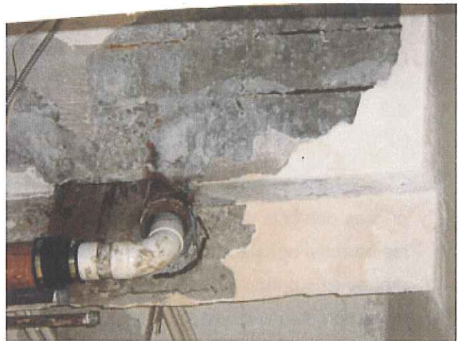
Poutre coupée pour passer tuyaux de mécanique
