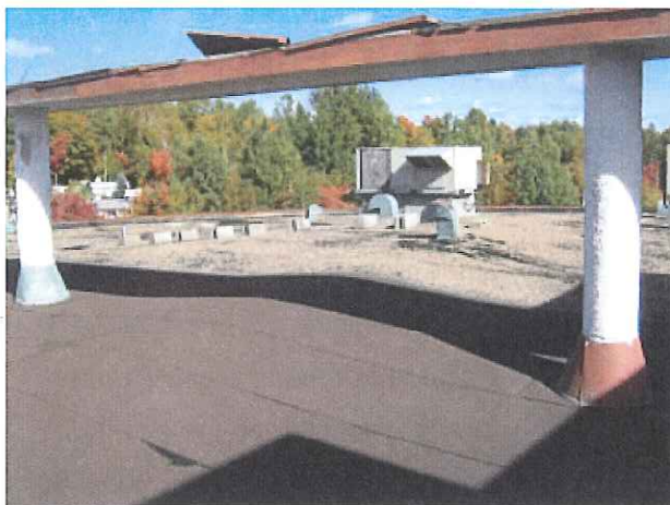
Structure de bois, solins et colonnes de la pergola
