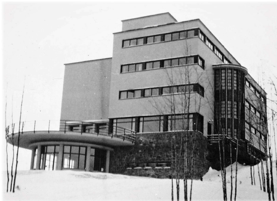
Figure 1 : L'hôtel de la Pointe-Bleue en 1940 (aujourd'hui démolie)
